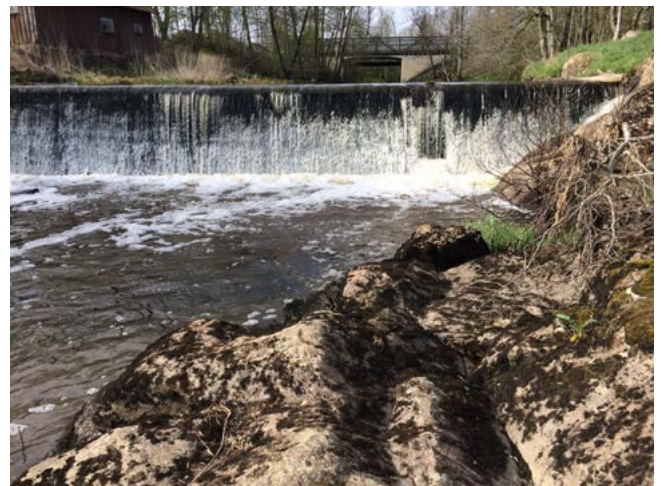
Lidan och Afsån är de två största åarna som rinner genom Vara kommun. De har båda stora biologiska värden. Äldre kraftverksdammar kan ha ett kulturhistoriskt värde men samtidigt utgöra ett hinder för vandrande fiskar och andra vattenlevande organismer.
